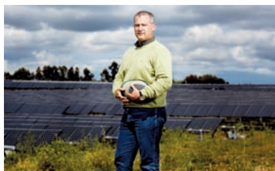
Centrale fotovoltaica Montalto di Castro, Viterbo.
